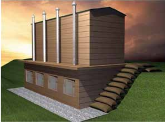
Зураг 2.109. Сумын эмнэлэг, сургууль, цэцэрлэгт барих боломжтой олон кабинтай хуурай жорлон
