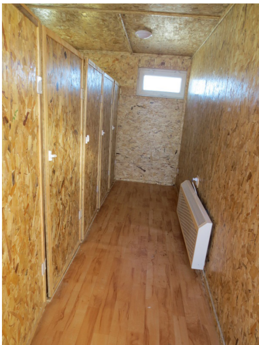
Зураг 24. Агааржуулагчтай сайжруулсан нүхэн жорлонгийн дотор тал /өндөр ханатай, хаалгатай тасалгаанууд/
