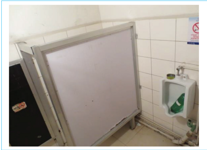
Зураг 3. Ариун цэврийн өрөөний таславчийг зай талбай бүрэн ашиглаагүй хийсэн, шээлтүүр нь ажилладаггүй
