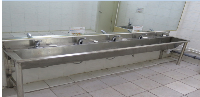
Зураг 17. Үргэлжилсэн урт угаагуур суурилуулж хуучин 3 байсан цоргыг 5 болгосноор хүртээмж нэмэгдсэн.
