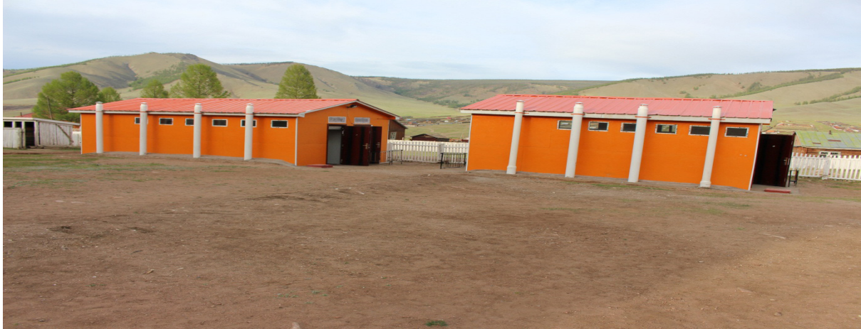
Зураг 27. Агааржуулагчтай сайжруулсан нүхэн жорлон ТАЙЛБАР: Эх сурвалж: “: “НҮБ-ын хүүхдийн сан” Хөвсгөл аймаг Түнэл сум
