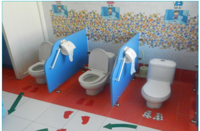
Зураг 43. Бүх шугам хоолойг далдалж, шал, ханыг цэвэрлэхэд хялбар плитагаар өнгөлсөн байдал
