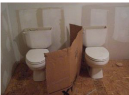
Зураг 7. Хувийн нууцлалыг хангаж чадахгүй суултуур хоорондын хаалт
