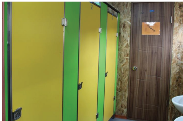
Зураг 8. Суултуур хооронд хийсэн өндөр ханатай, тусдаа хаалгатай, дотор талдаа түгжээтэй хаалтууд
